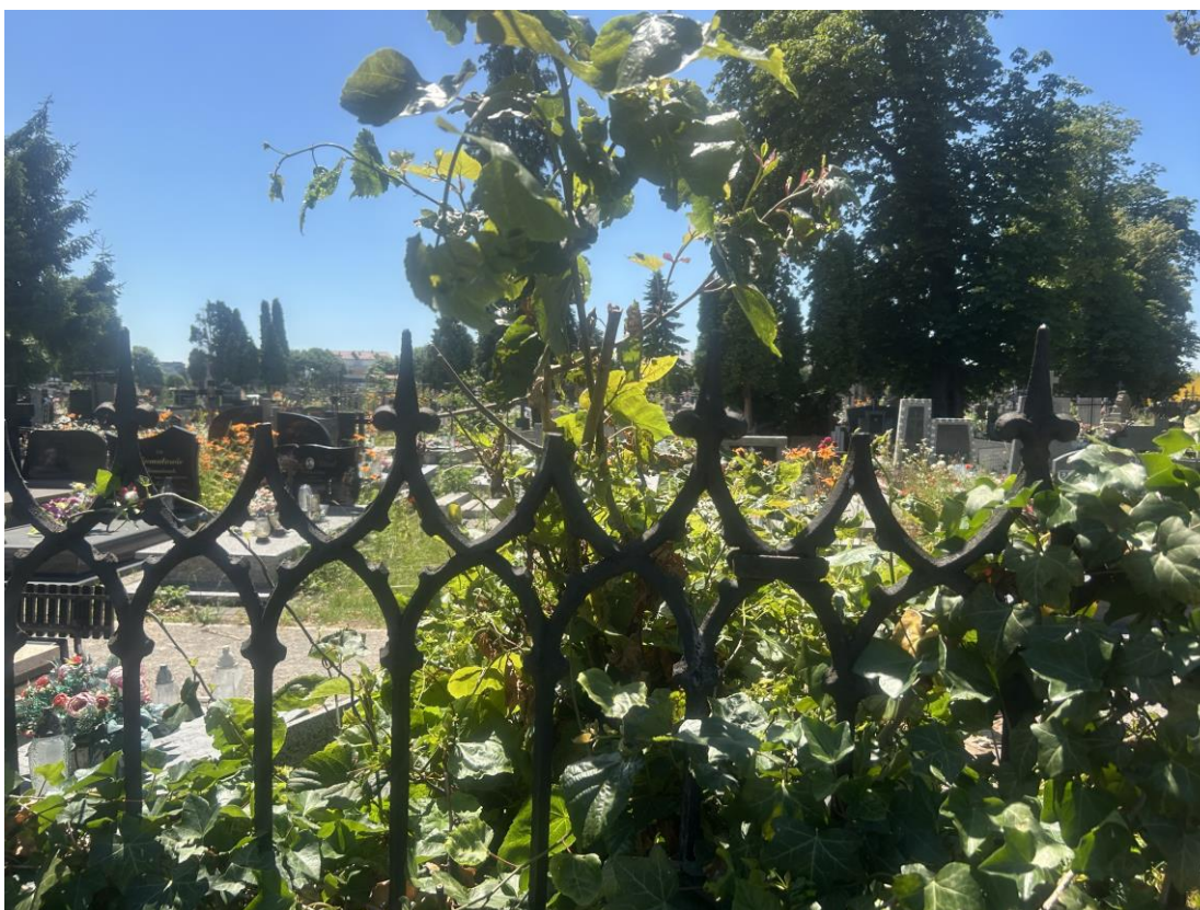
Fot. 14. Metalowe przęsto ogrodzenia. Element przemalowany co najmniej dwiema warstwami farby w kolorze czarnym.
