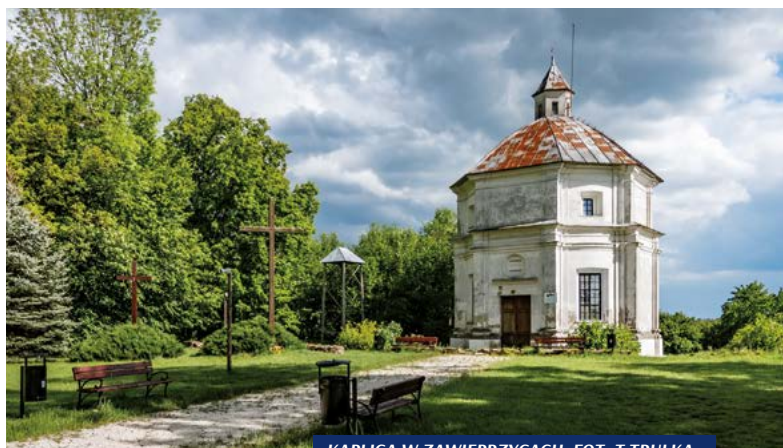
KAPLICA W ZAWIEPRZCACH, FOT. T. TRULKA
