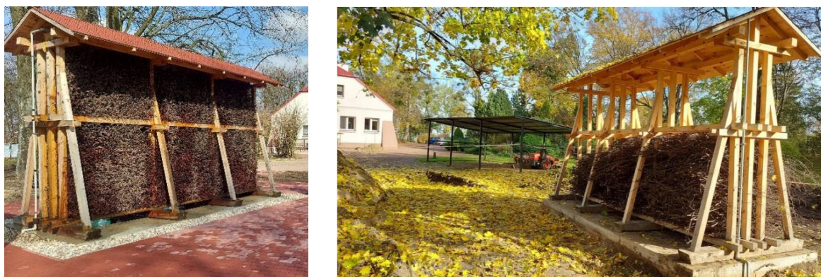
Fot.4. Tężnia solankowa przy Ośrodku Rewalidacyjno - Wychowawczym w Łęcznej
