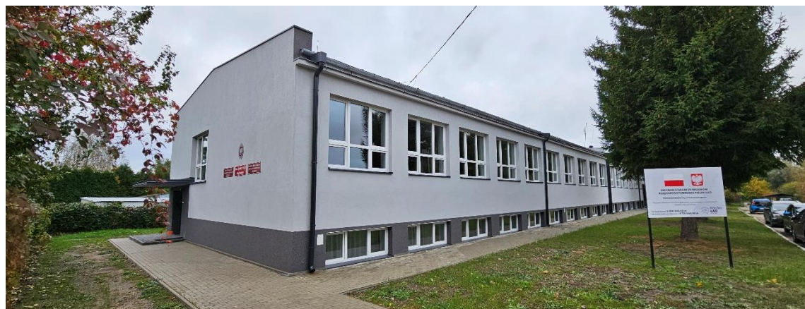
Fot. 2. Termomodernizacja budynku szkolnego w Młodzieżowym Ośrodku Wychowawczym w Podgłębkiem
