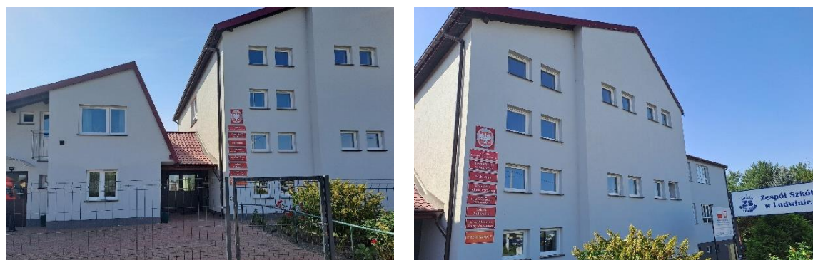
Fot. 3. Termomodernizacja budynku Zespołu Szkół w Ludwinie
