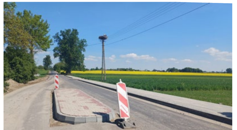
Przebudowa drogi powiatowej nr 1808L w miejscowości Stręczyn
