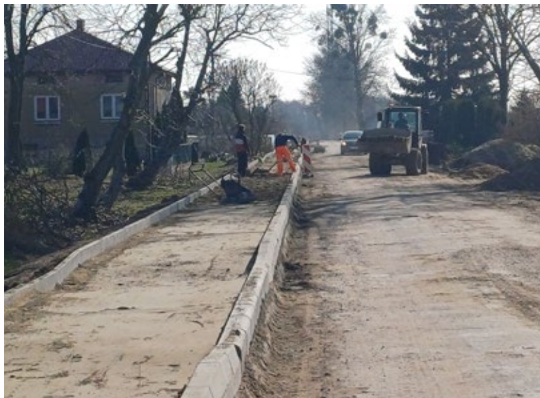
Przebudowa drogi powiatowej nr 1808L w miejscowości Stręczyn
