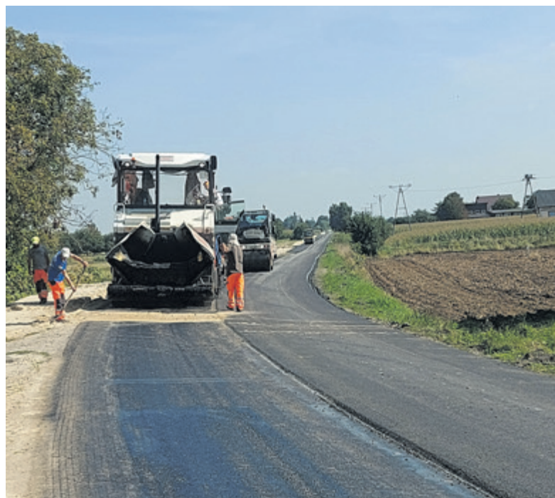
Przebudowa drogi w Starościcach. Fot. arch. ZDP w Łęcznej
