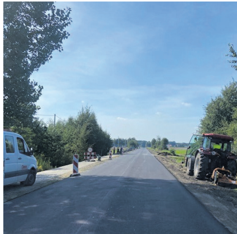
Przebudowa drogi w Dąbrowie. Fot. arch. ZDP w Łęcznej
