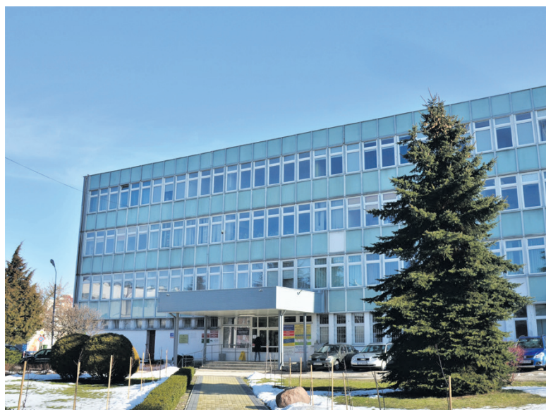
W 2021 r. zaplanowano również rozbudowę, przebudowę i termomodernizację budynku przy al. Jana Pawła II 95. Fot. arch. Starostwa
