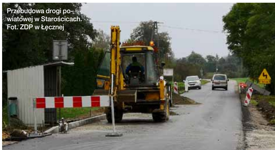
Przebudowa drogi powiatowej w Albertowie. Fot. ZDP w Łęcznej
