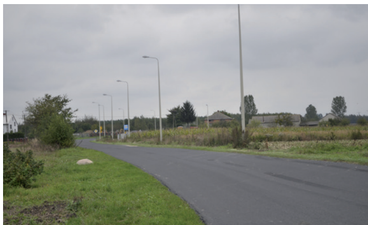
Nowa nawierzchnia na drodze powiatowej w Zawadowie
