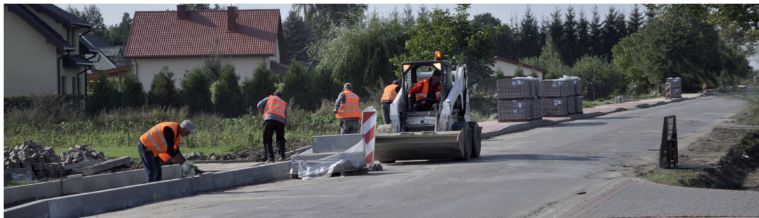
Trwają prace na drodze powiatowej na ul. Polnej w Łęcznej
