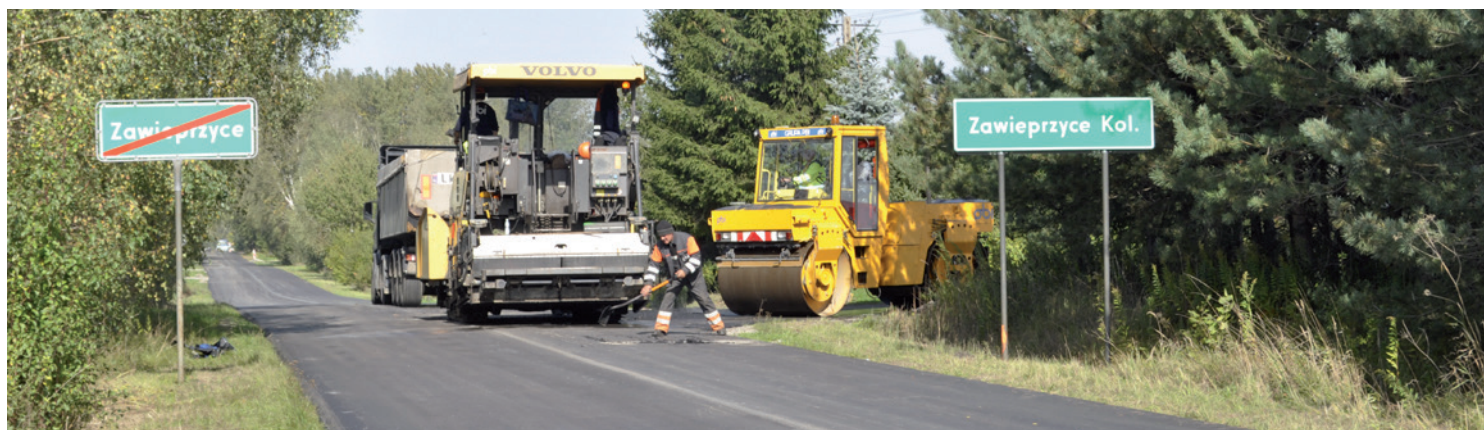
Wymiana nawierzchni na drodze powiatowej Zawieprzycze – Zawieprzycze Kolonia. Fot. B.Cieślińska
