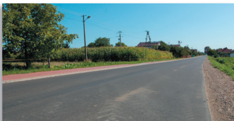
Przebudowa drogi powiatowej nr 2014 L: Stara Wieś – Turowola
