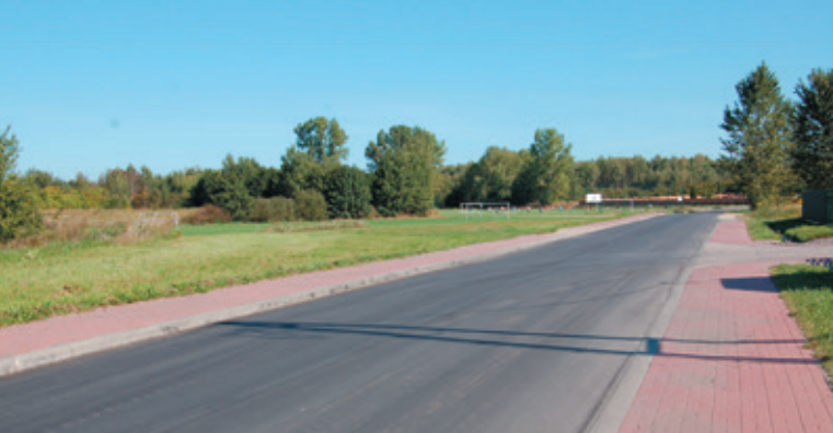
Nowa nawierzchnia drogi powiatowej nr 2006 L: Ludwin – Dratów Kolonia
