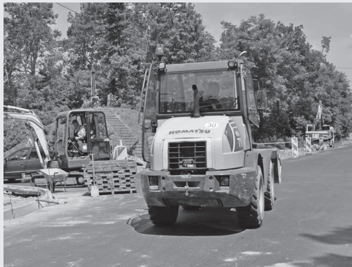
Przebudowa skrzyżowania w Ciechankach. Fot. B. Cieślińska
