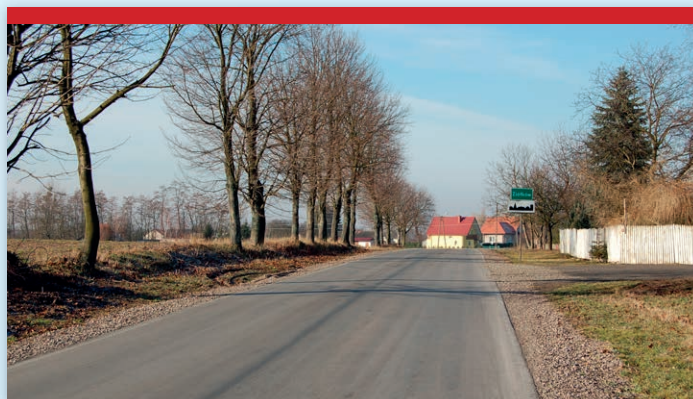
Przebudowa drogi powiatowej Nr 2003L Ziółków – Witaniów (2014 – 2016)
