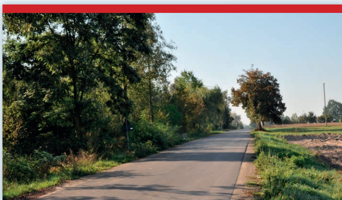
Przebudowa drogi powiatowej Nr 2006L Ludwin - Dratów Kolonia (2016 – 2018)
