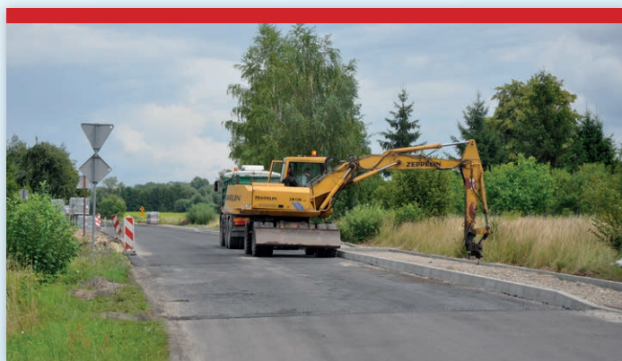
Rozbudowa drogi powiatowej Nr 1716 L Nadrybie – Urszulín (2018)
