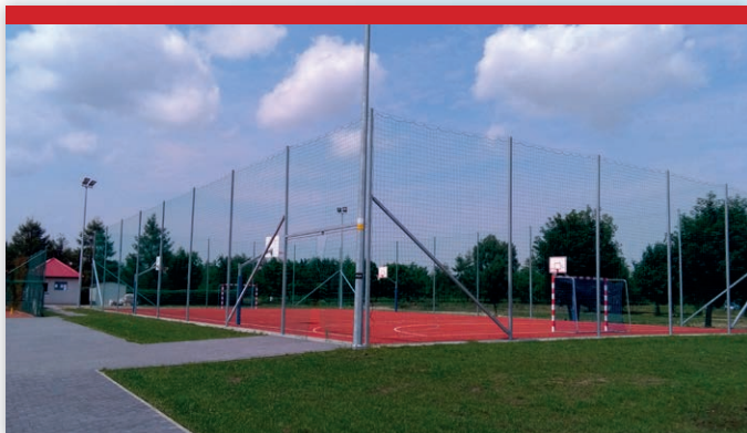
Boisko wielofunkcyjne na terenie kompleksu sportowego przy ul. Bogdanowicza w Łęcznej.
