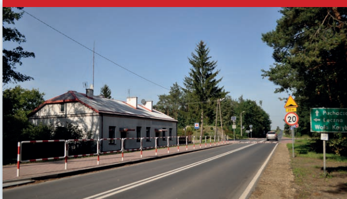
Przebudowa drogi powiatowej Nr 2015 L Puchaczów – Ciechanki (2017)
