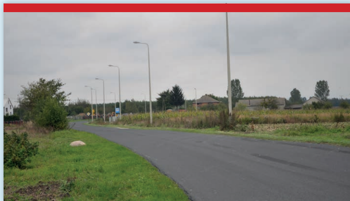
Przebudowa drogi powiatowej Nr 1809 L Szpica – Zawadów (2016 – 2018)
