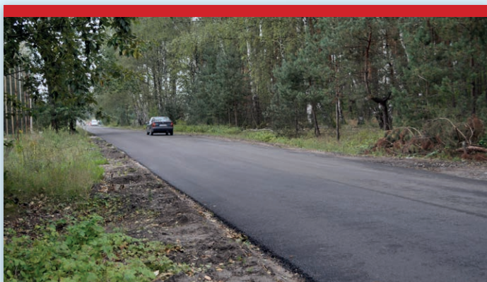
Przebudowa drogi powiatowej Nr 1564 L Zawieprzycze - Zawieprzycze Kolonia (2017-2018)
