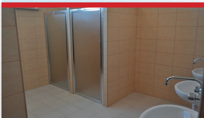
Zmodernizowane zaplecze sanitarne przy sali gimnastycznej w ZSG w Łęcznej.
