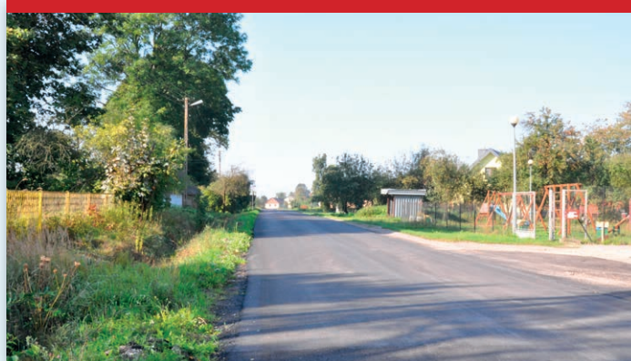
Przebudowa drogi powiatowej Nr 2009 L w m. Zaróbka i Kopina (2018)
