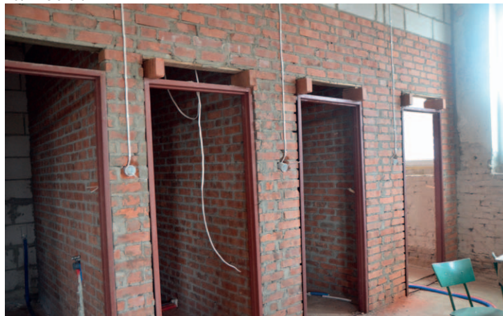
Hale warsztatowe ZSG w Łęcznej przy ul. Przemysłowej 16 – budowane pomieszczenia socjalne. Fot. A. Giszczak
