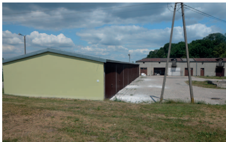
Remontowane budynki i plac warsztatowy w Zespole Szkół Rolniczych w Kijanach.
