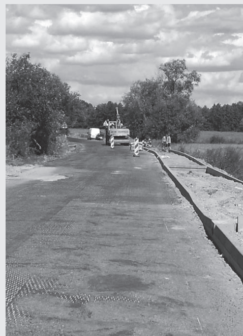
Prace modernizacyjne na drodze Nadrybie-Urszulin. Fot. arch. ZDP w Łęcznej
