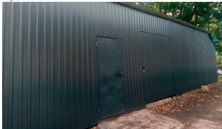
Wiaty magazynowa, z wymienioną obudową przy warsztatach ZSG na ul. Przemysłowej 16 w Łęcznej. Fot. A. Giszczak
