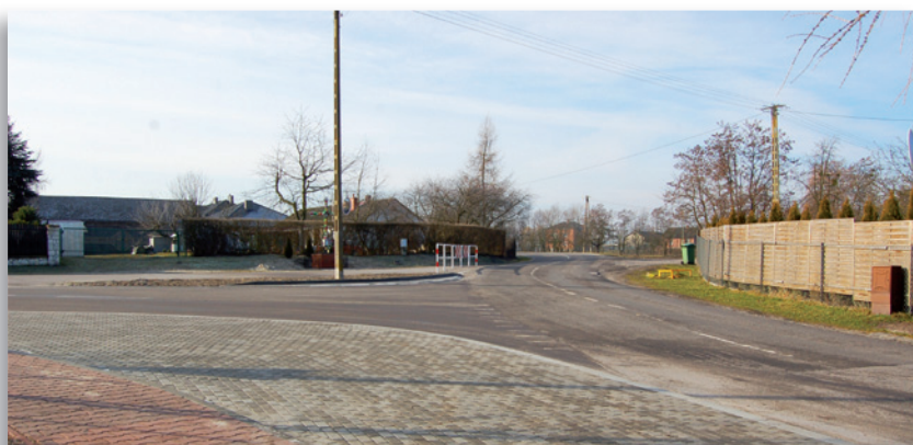
Przebudowa skrzyżowania drogi gminnej nr 105288L w m. Ostrówek z drogą powiatową nr 2028L
