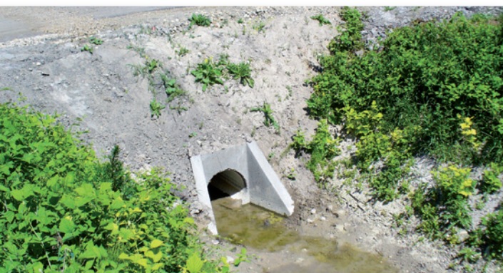
Modernizacja urządzeń melioracji wodnej podczas scalania gruntów we wsiach Szczupak i Ostrówek Podyski
