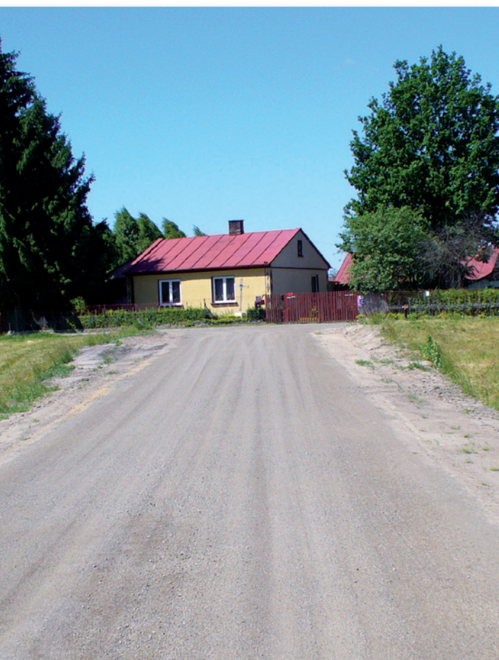
Przebudowa dróg gruntowych w ramach prac scaleniowych
