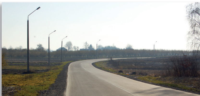
Modernizacja drogi powiatowej nr 2003L Ziółków – Karolin – Witaniów
