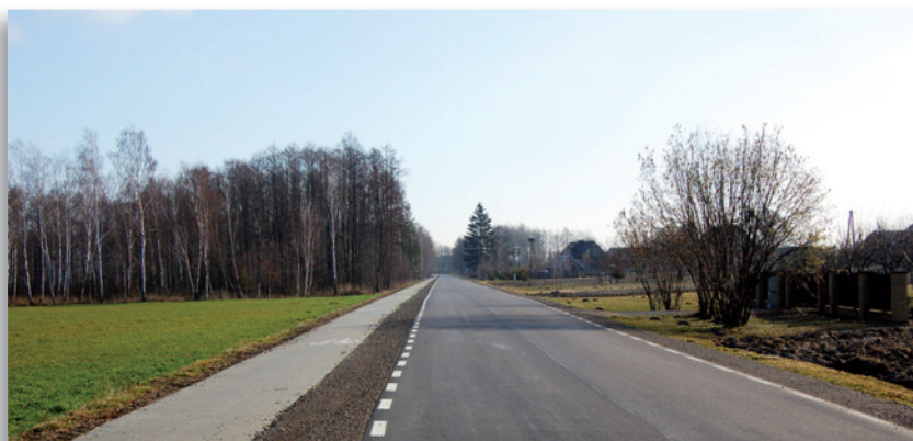
Przebudowa drogi powiatowej nr 1625L i 2007L – etap II. Odcinek w m. Kaniwola
