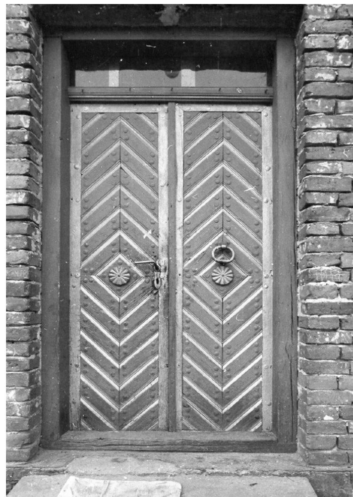
Fot. 4. Oryginalne drzwi wejściowe dworu Bogdanowiczów. Fotografia z 1985r. Zdjęcie pochodzi ze zbiorów p. M. Kseniaka.
