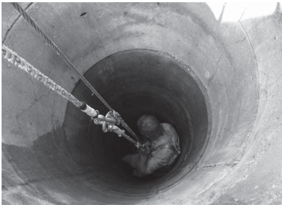
Fot. 16. Widok w głąb studni (stan obecny).
