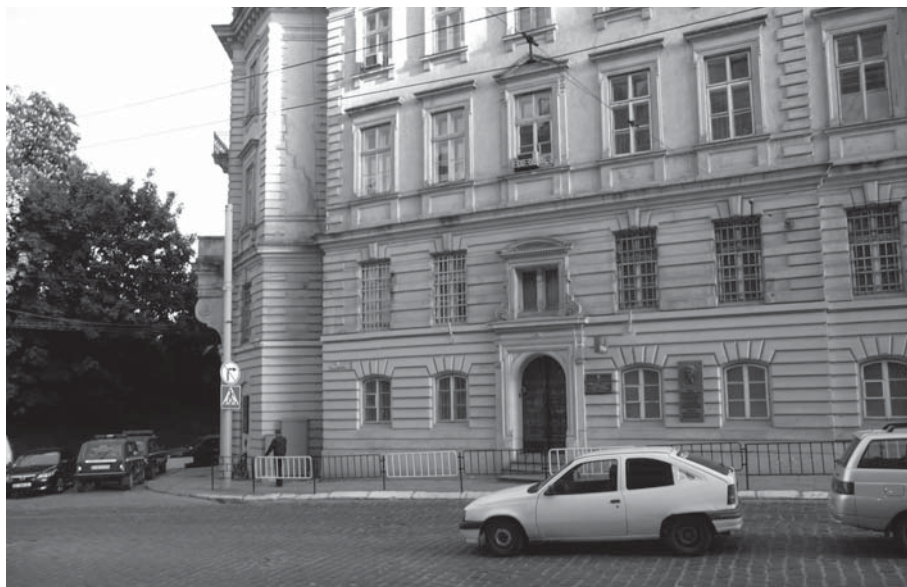
Fot. 11. Fragment budynku dawnego więzienia przy ul. Łąckiego we Lwowie (widok obecny od ul. S. Bandery).
