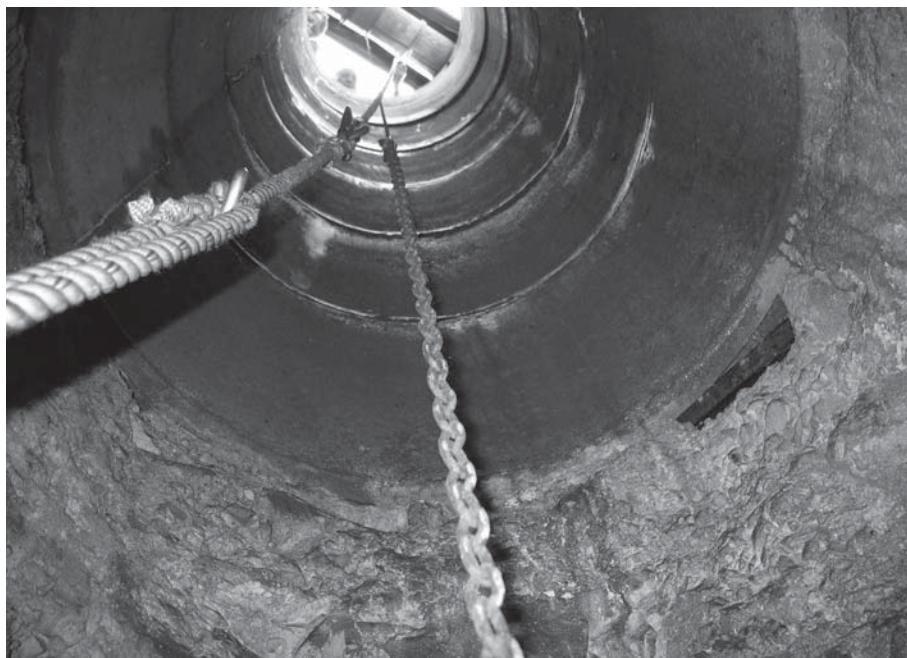
Fot. 17. Widok z głębi studni (stan obecny).
