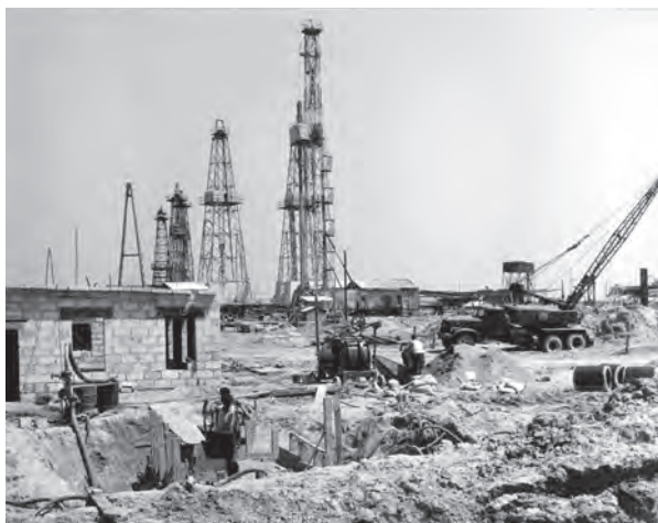
Plac budowy kopalni w Bogdancie.
